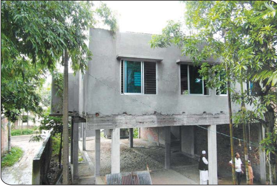
কুমিল্লায় নির্মাণাধীন আহমদীয়া মসজিদের বর্তমান অবস্থা The under-construction Comilla Ahmadiyya Mosque
