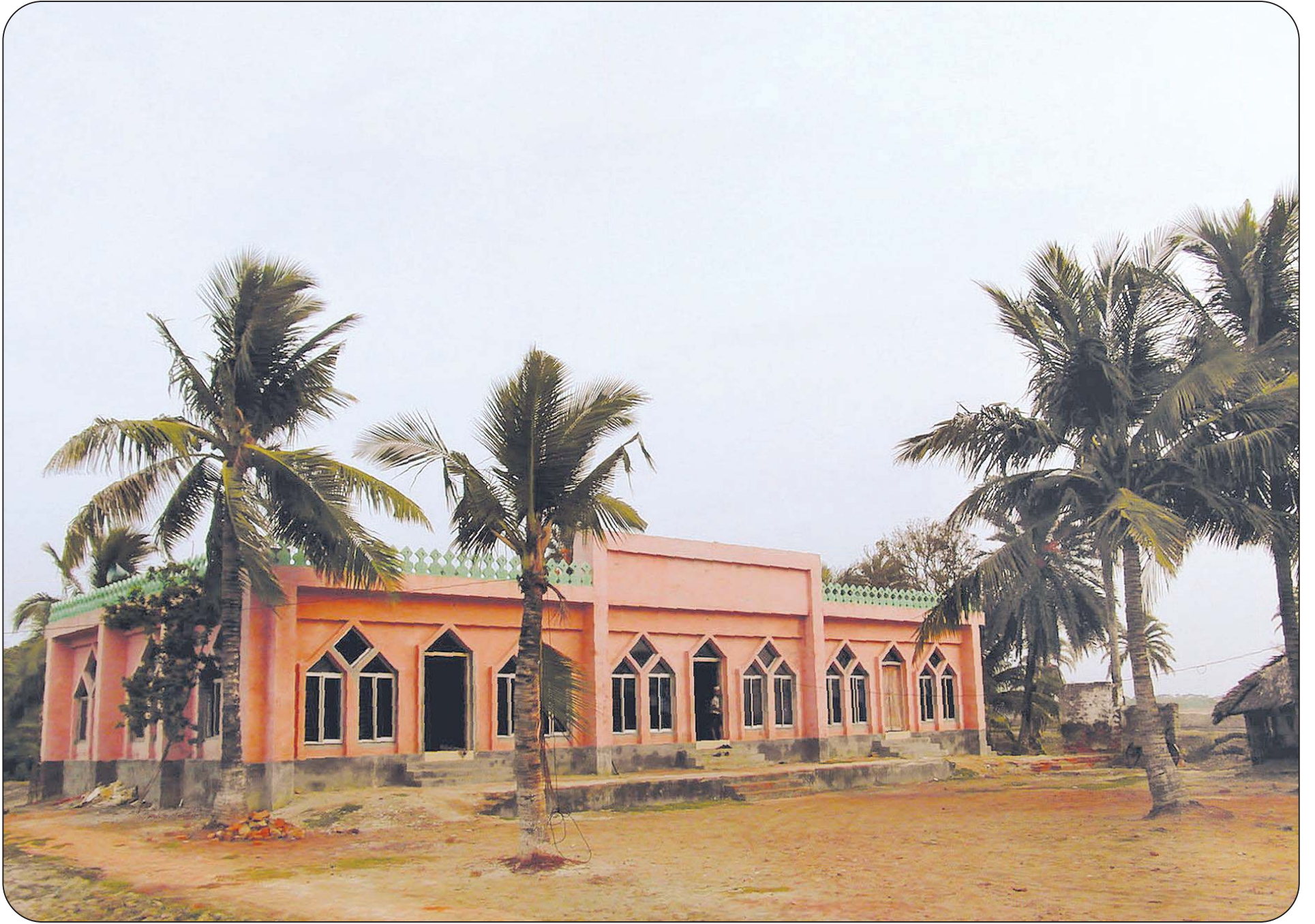
পুনর্নির্মাণের পর মসজিদ বায়তুস্ সালাম, সুন্দরবন, সাতক্ষীরা Recently reconstructed Masjid-e-Baitus Salam, Sundarban Ahmadiyya Mosque, Shatkhira
